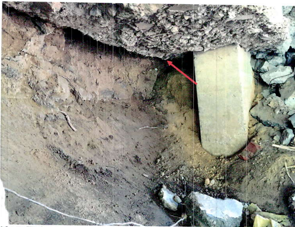
19.att. Trūkst konusa nostiprinājuma. Bīstams paskalojums zem krasta balsta Nr.1.
