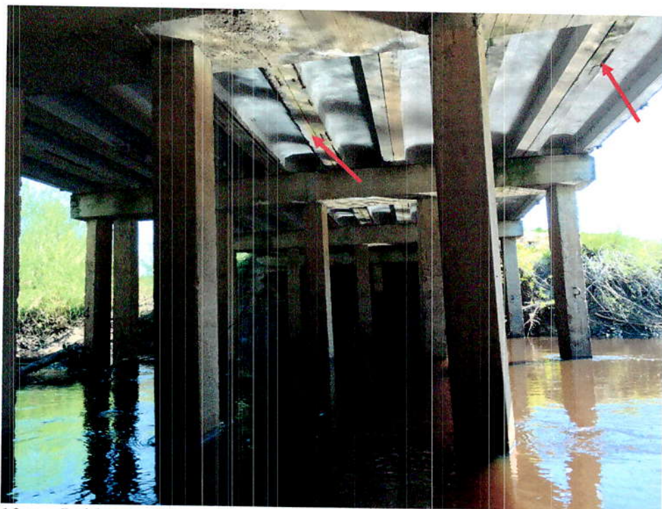
13.att. Laiduma plātnēm korozijas plaisas, drūp betons, korodē darba stiegrojums un cauri sūcas ūdens. Skats 3.laidumā.
