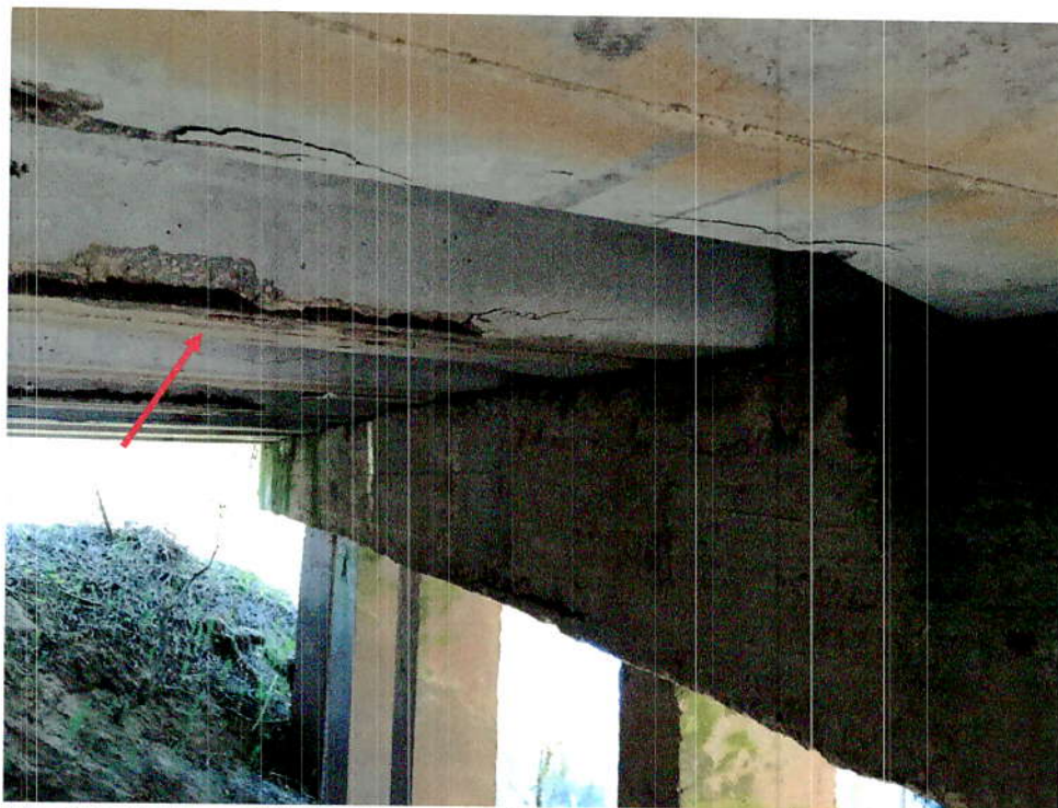
17.att. Laiduma plātnēm korozijas plaisas, drūp betons, korodē darba stierojums un cauri sūcas ūdens. Skats 5.laidumā.
