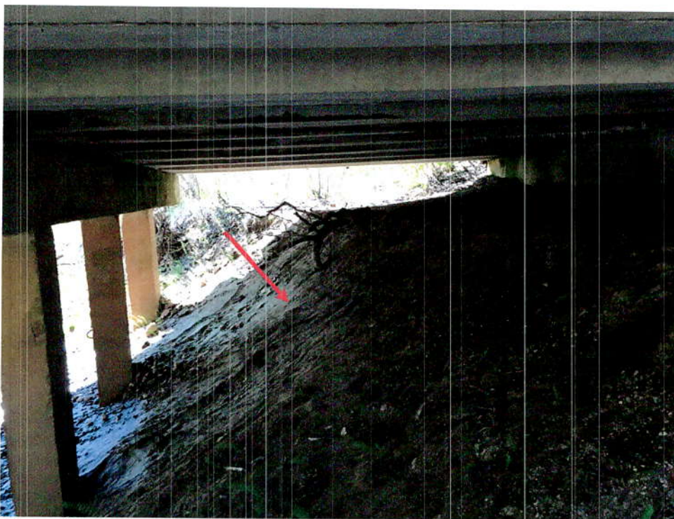
20.att. Trūkst konusa nostiprinājuma. Skats uz krasta balstu Nr.6.
