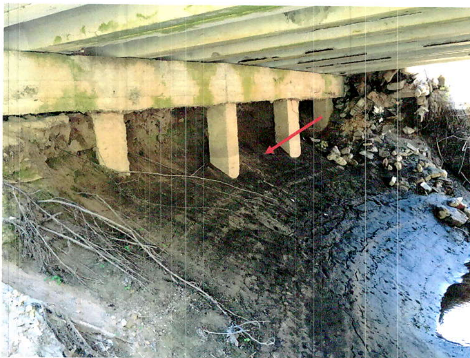
18.att. Trūkst konusa nostiprinājuma. Bīstams paskalojums zem krasta balsta Nr.1.
