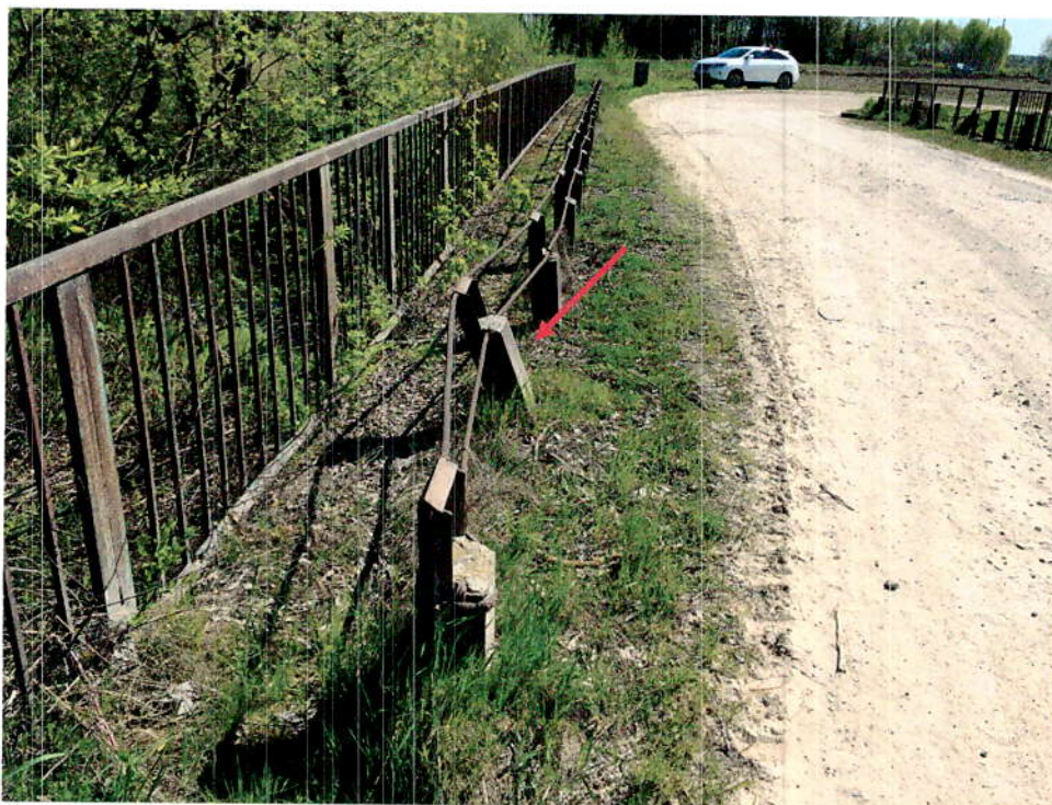
8.att. Bojāta barjeru konstrukcija. Skats 5.laidumā augšteces pusē.
