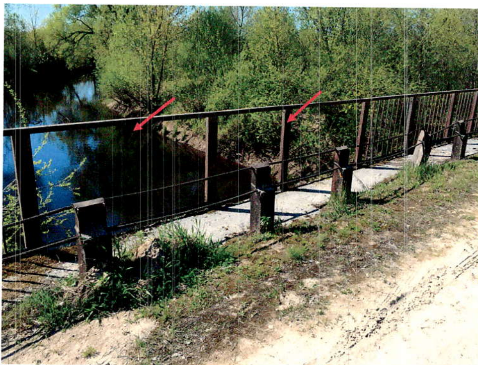
6.att. Trūkst aizpildījums margu konstrukcijai. Skats 2.laidumā lejteces pusē.
