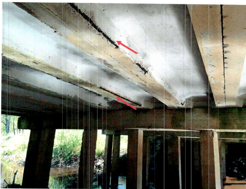
14.att. Laiduma plātnēm korozijas plaisas, drūp betons, korodē darba stiegrojums un cauri sūcas ūdens. Skats 4.laidumā.
