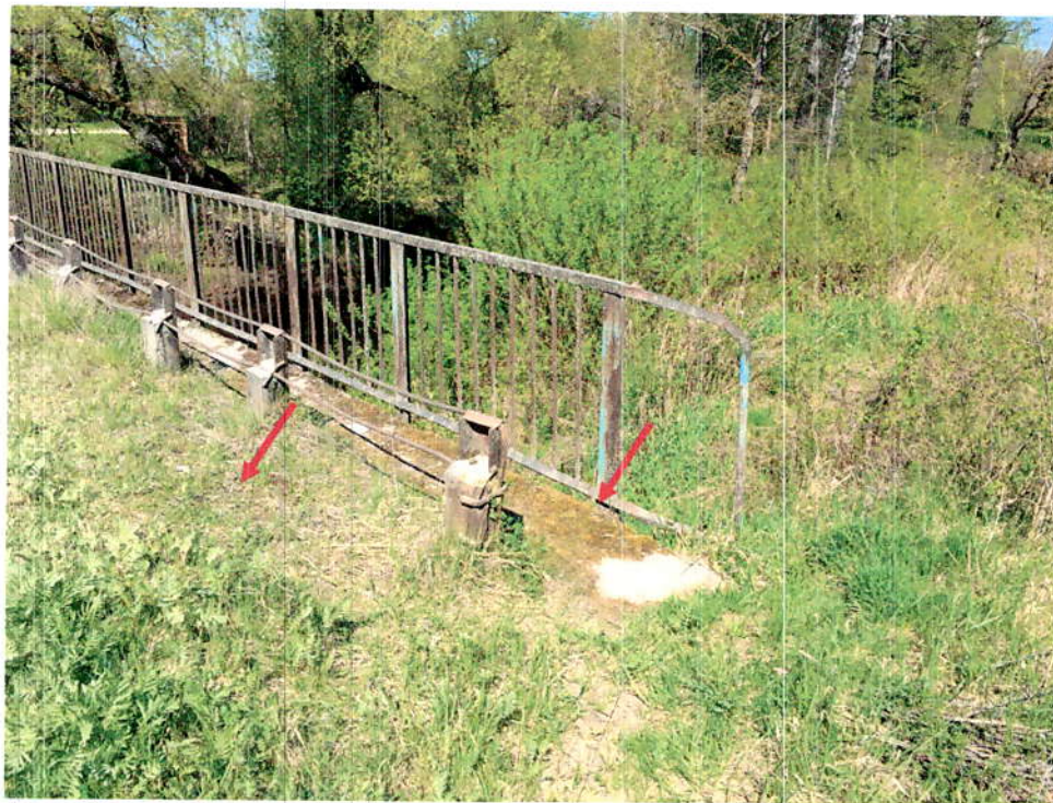
4.att. Sanesumi un apaugums uz cementbetona seguma un ietves. Skats no Namiķu puses
