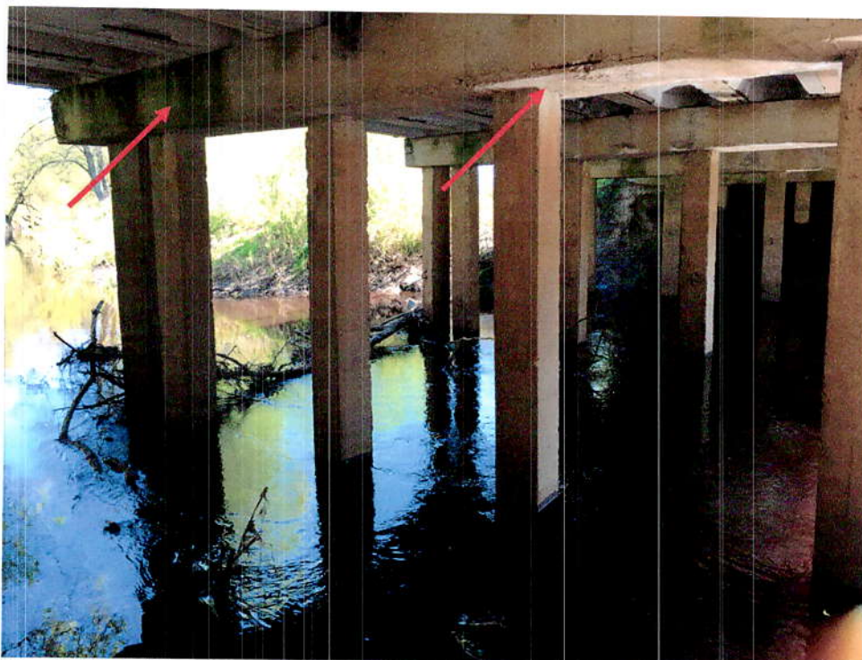
21.att. Notecējumi uz uzkalas. Vietām betona izdrupumi, korodē konstruktīvais stiebrojums. Skats uz upes balstu Nr.5.
