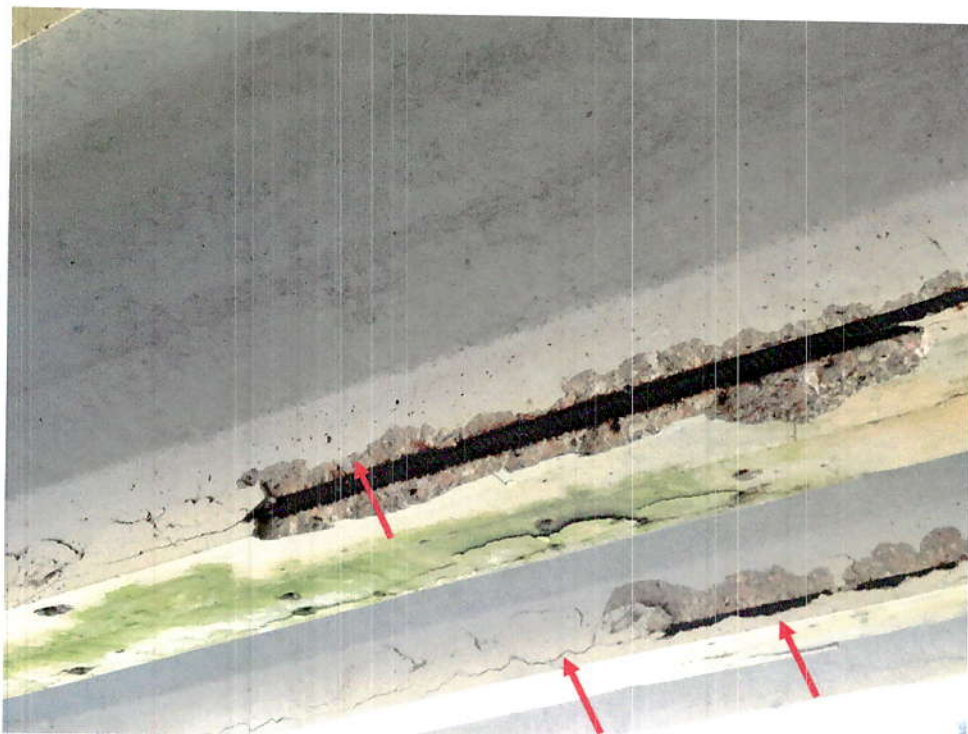
11.att. Laiduma plātnēm korozijas plaisas, drūp betons, korodē darba stiebrojums un cauri sūcas ūdens. Skats 1.laidumā.
