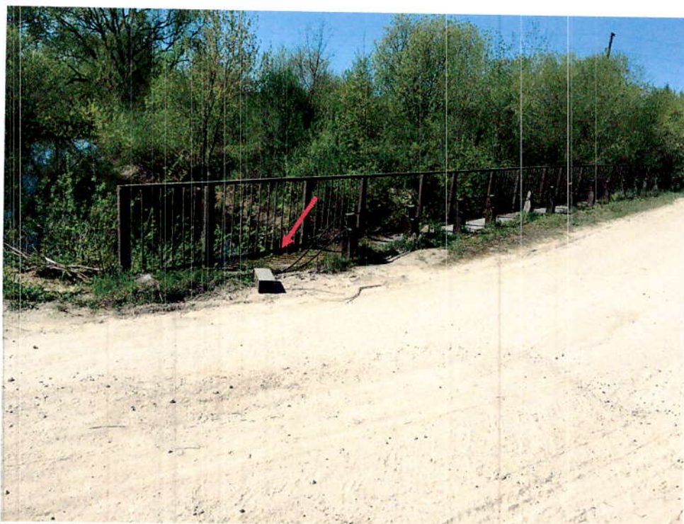
7.att. Salauzta barjeru konstrukcija. Skats 1.laidumā lejteces pusē.
