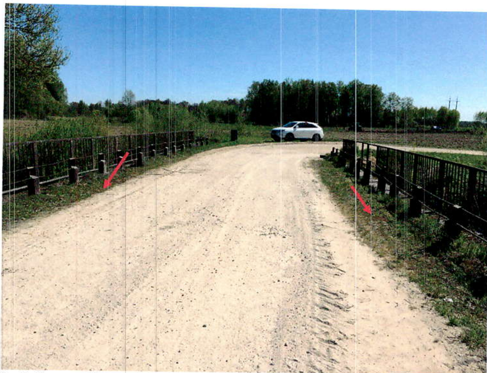
3.att. Sanesumi un apaugums uz cementbetona seguma. Skats no Birzulu puses
