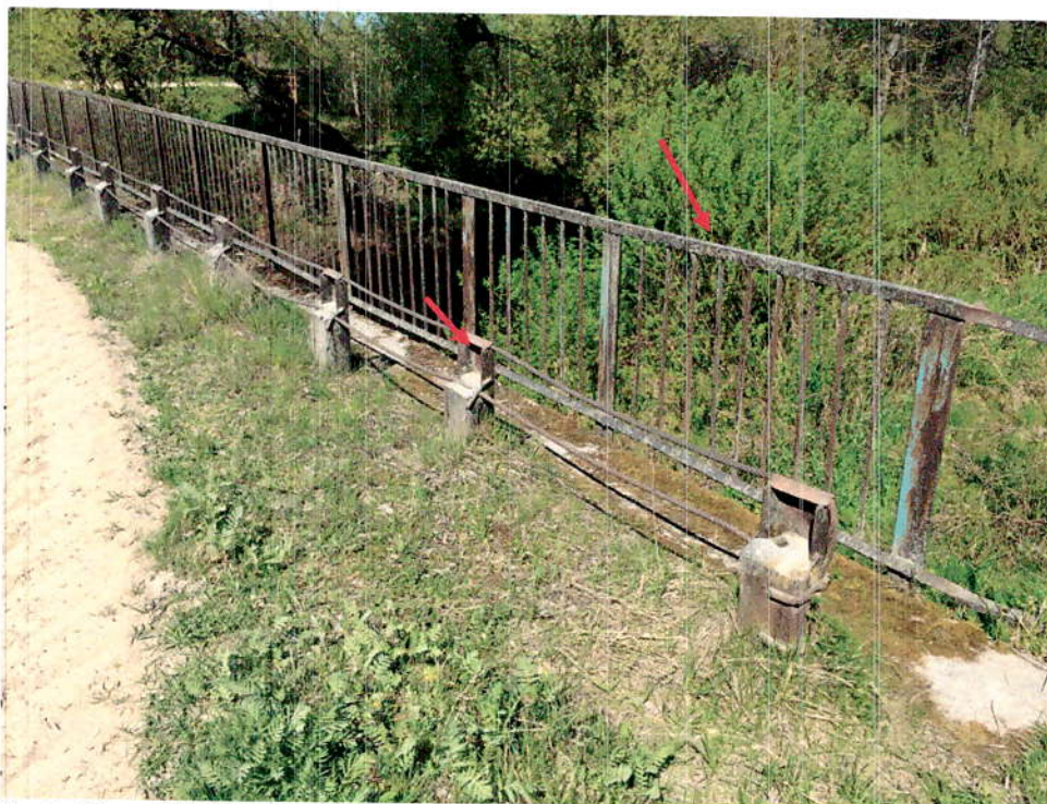
5.att. Korodējušas margas un barjeras, vietām bojājumi. Skats augšteces pusē.
