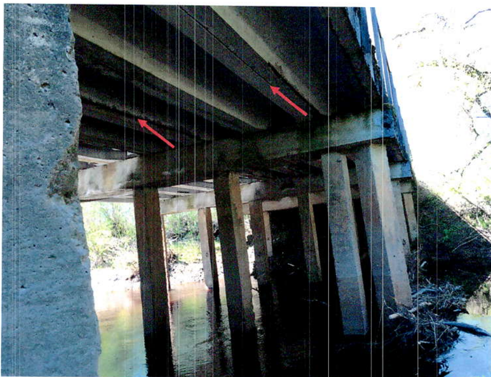
12.att. Laiduma plātnēm korozijas plaisas, drūp betons, korodē darba stiebrojums un cauri sūcas ūdens. Skats 2.laidumā.
