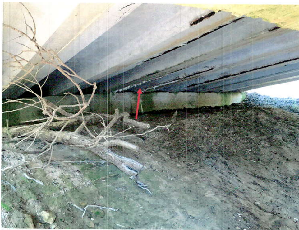
16.att. Laiduma plātnēm korozijas plaisas, drūp betons, korodē darba stiebrojums un cauri sūcas ūdens, stalaktīdi. Skats 5.laidumā.
